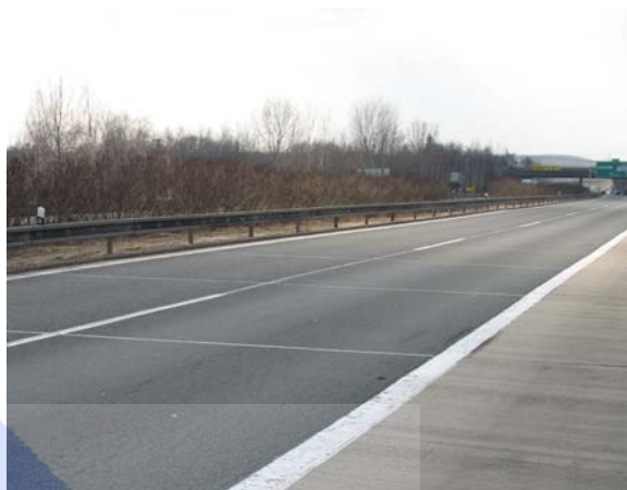
Přiznání spár na mikrokoberci - prořezané a utěsněné spáry
