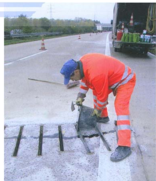
Průběh kotvení trhliny pomocí horizontálních kotev
