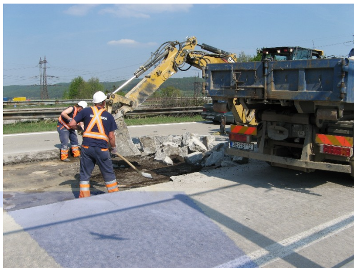
Vybourání starých betonových desek
