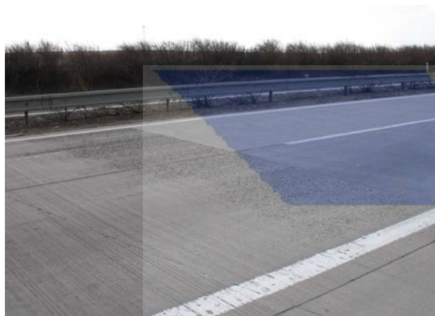
Odstranění schůdku na příčné spáře frézou
