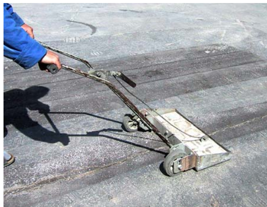
Sesbírání zbylých ocelových kuliček magnetickým sběračem
