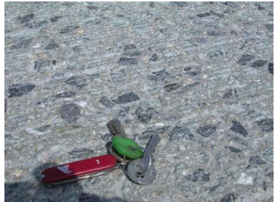
Stav povrchu po frézování
