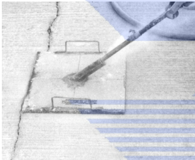
Průběh vrtání kotevních otvorů přes nástavec udávající úhel vrtu
