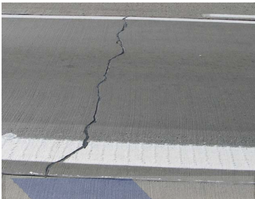
Utěsnění pasivní trhliny bez rozšíření
