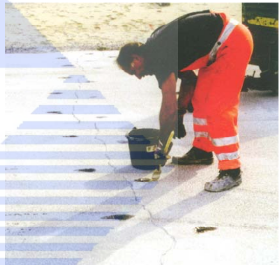
Doplnění vrtů polymerní maltou a zarovnání s povrchem desky
